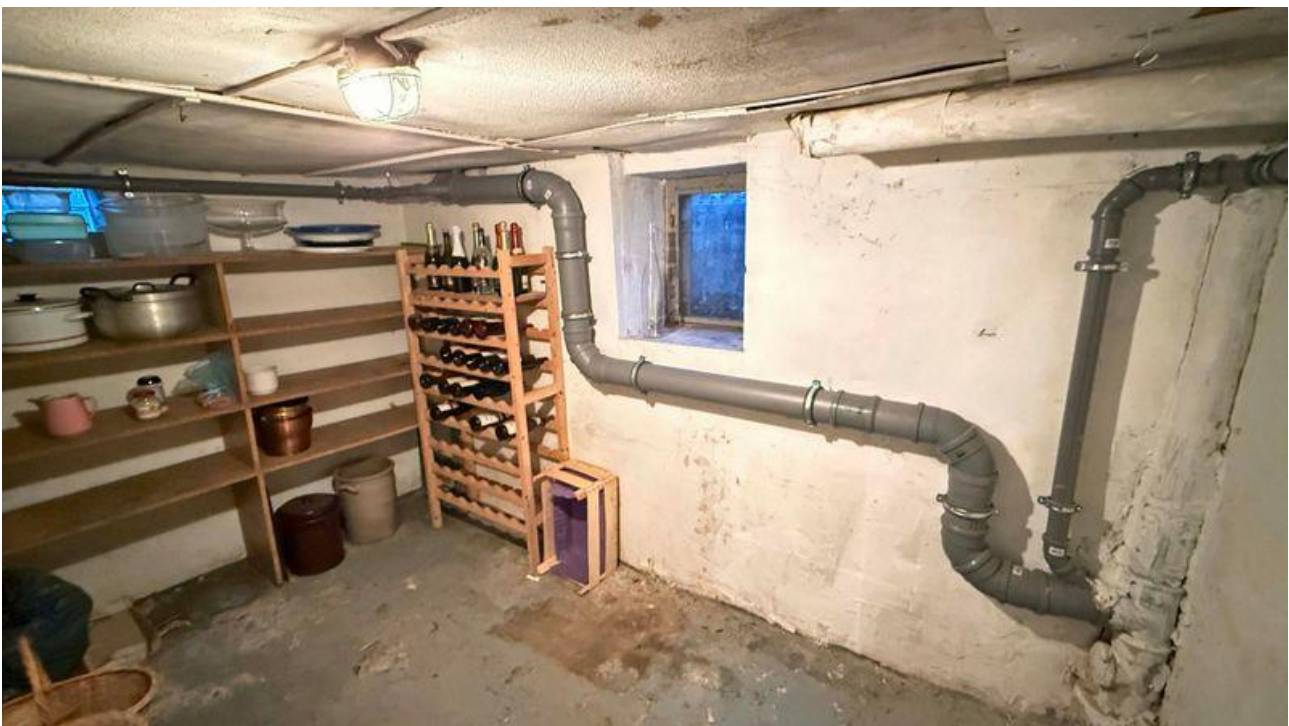
Installationen sind größtenteils modernisiert
